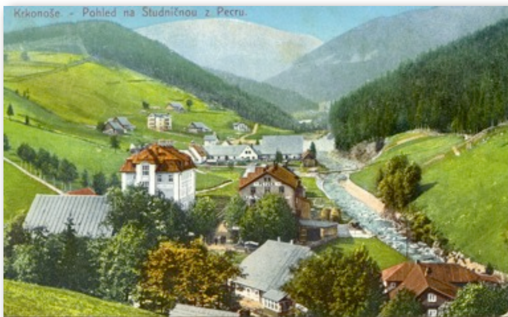
Pec pod Sněžkou se Studniční horou v pozadí
